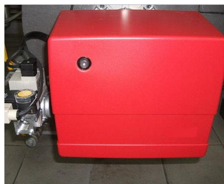
9) Переустановите кожух и Подключите газовую арматуру к газопроводу
