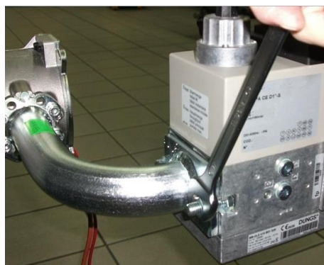
8) установить электроклапан и Прикрепить из фланец;
