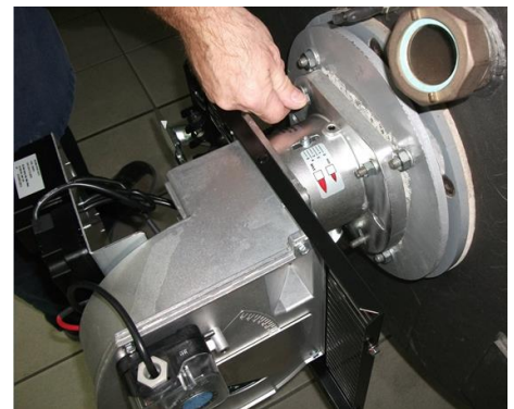
6) Зафиксировать горелки на котел;
